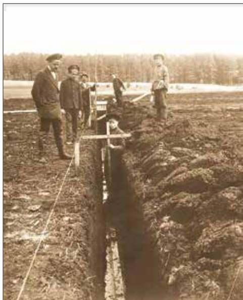
Укладка дренажа системы Бутца на МБОС, 1915 г.
